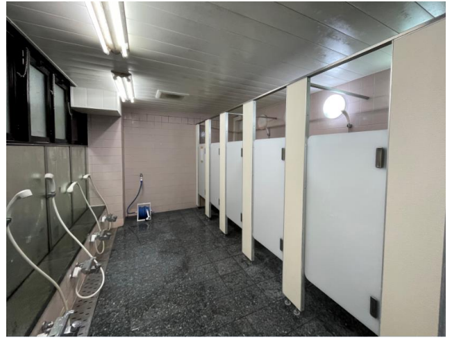
< 浴室内シャワー Shower room in public bath >
