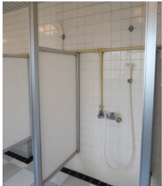
< 浴場内シャワー Shower in the bathroom >
