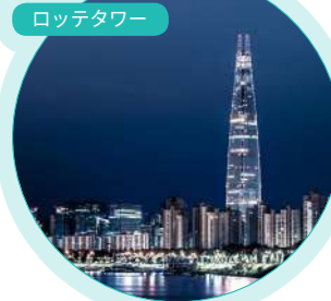
ロッテタワー
